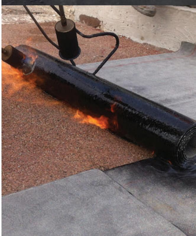
Koristeći višekomponentne hidroizolacijske materijale nove generacije uspješno saniramo sve vrste građevina od utjecaja i prodora kapilarne vlage.
